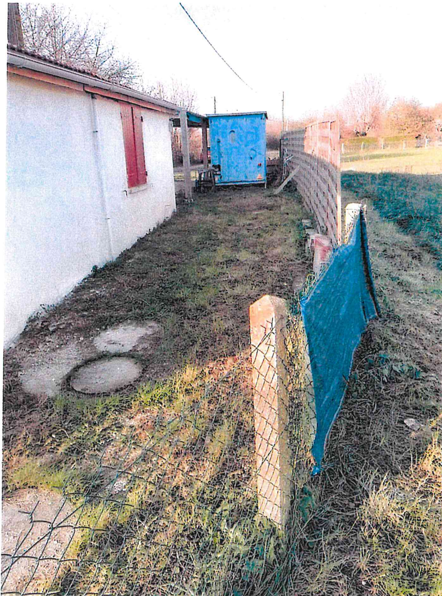
Fosse septique et compteur eau
